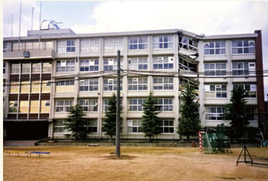
(A高校の被害)右側3スパンが崩壊
