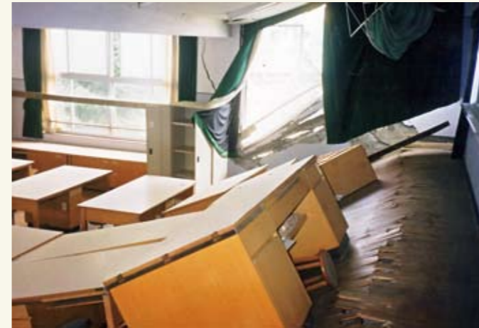
教室内の状況(床の落壊)
