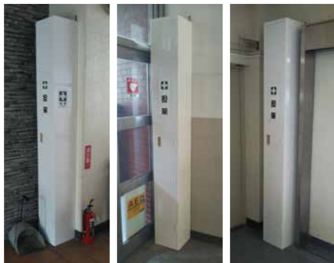
4号館設置 1号館設置 2号館設置
