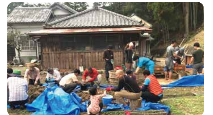
古民家改修プロジェクト 土壁の土づくりを行う様子
