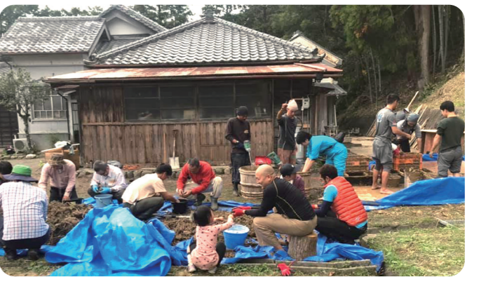
古民家改修プロジェクト 土壁の土づくりを行う様子
